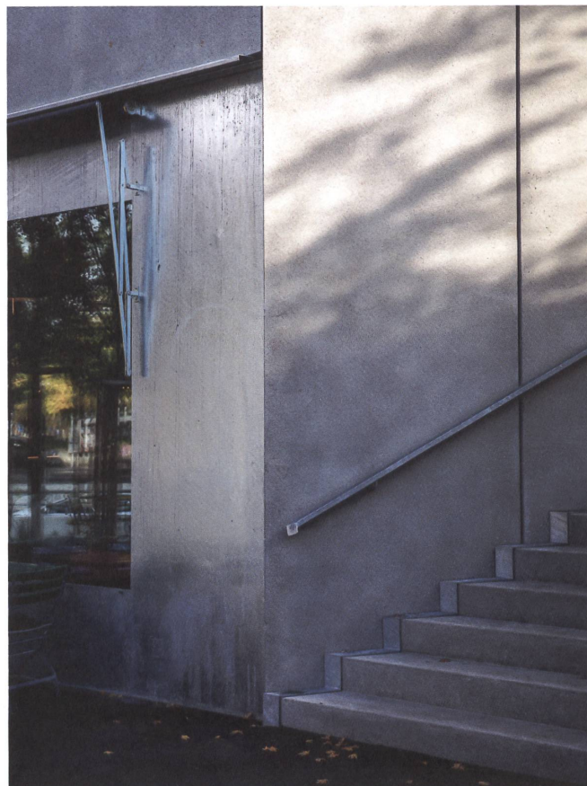
Verzinkte Stahlprofile an den mit Zinkblech verkleideten Ladenfronten.
