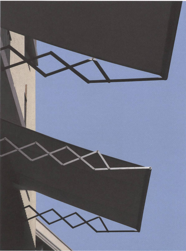
Scherearmstore in ausgefahrenem Zustand.
