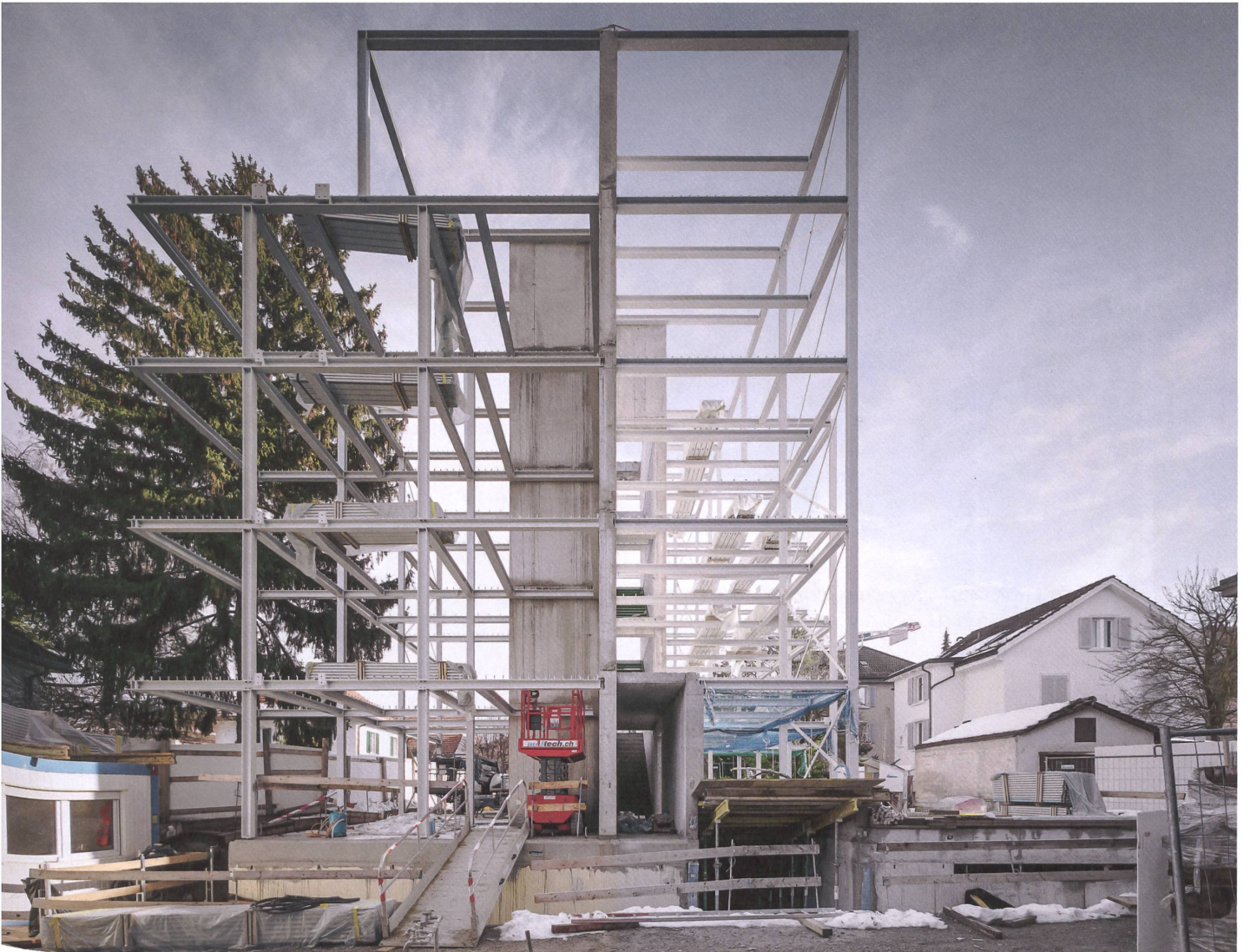
Am Herbstweg in Zürich adaptieren Graser Troxler Architekten ein Stahl-Beton-Verbundsystem aus dem Industriebau für eine Wohnnutzung.
