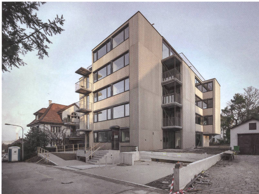
Der Sonderling im Quartier trägt ein Kleid aus Holzrahmen und Aluminiumblech.
