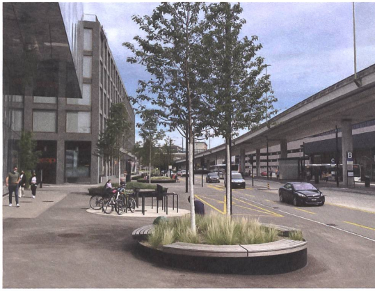
Den neuen Freiraum zwischen Glattzentrum und Richti-Areal teilen sich Fussgängerin, Auto, Bus und Stadtbaum. Foto: Martin Burri
