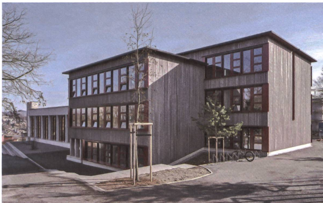
Die Erweiterung aus Holz ergänzt die bestehenden Betonbauten.
