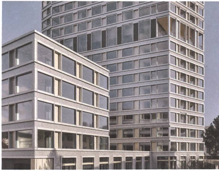
Die Alu-Fassade verwebt horizontale und vertikale Bänder.
