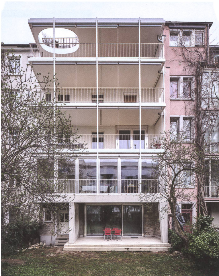
Feine Stahlstützen und Holzelemente als Decken fügen sich zur neuen Raumschicht.
