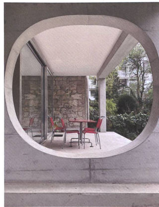
Die Superellipse in Beton dient auch als Sitzbank.
