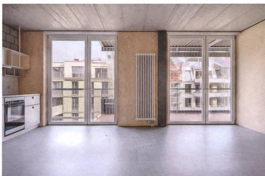
Einfach materialisiert: Beton, Kalksandstein, Sperrholz und Linoleum.
