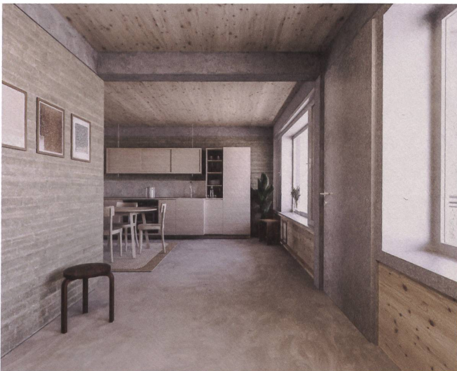
Lehsteinwände und Betonunterzüge prägen die Wohnungen.
