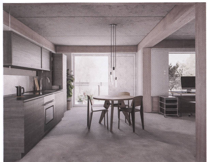
Das Holzskelett trägt Betonverbunddecken.
