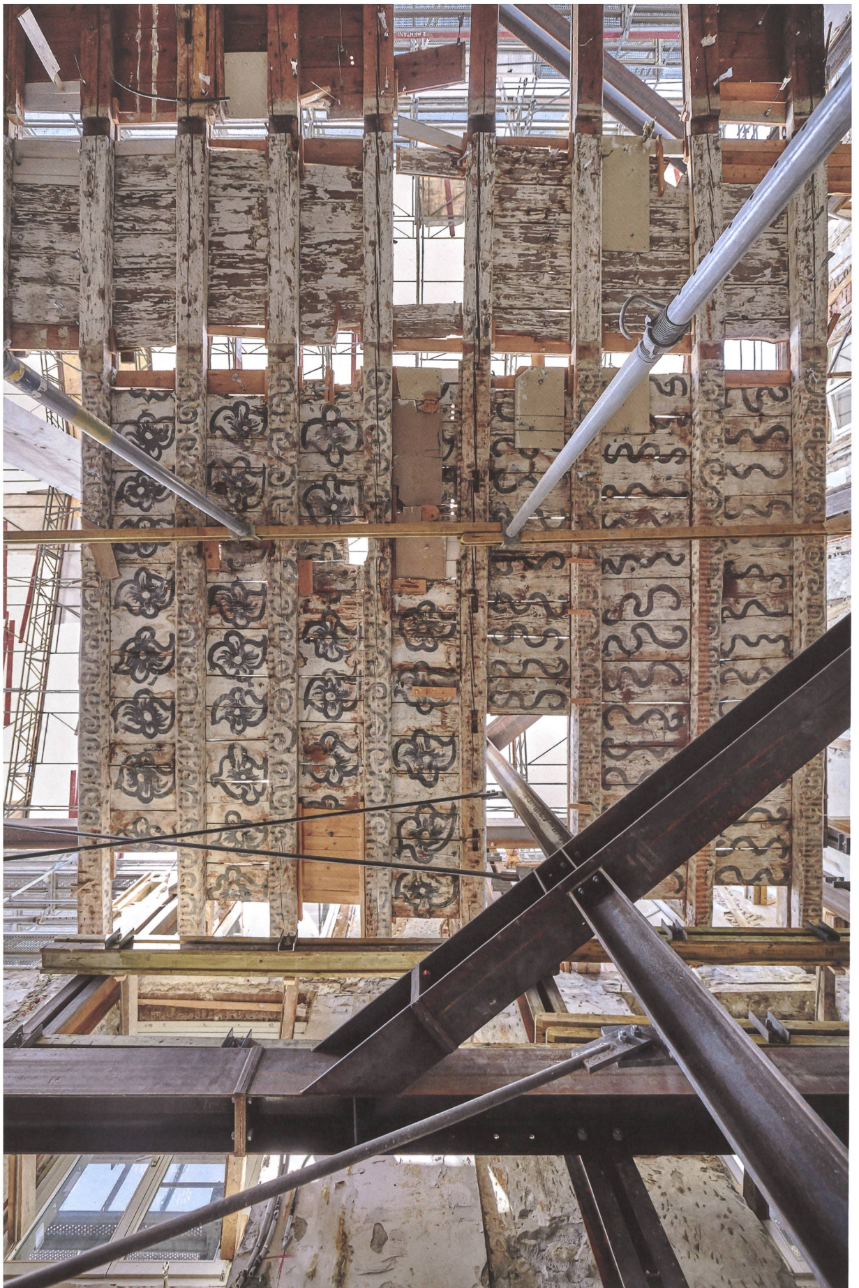
Die historische Decke im «Adler» musste aufwendig gesichert werden.
