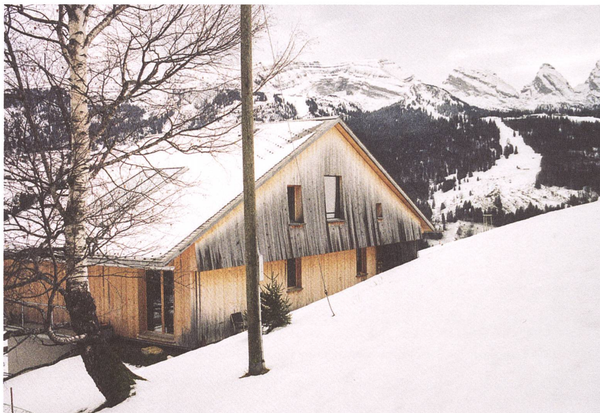
Die Schalung am Abwurfdach an der Nordfassade vergraut zusehends.
