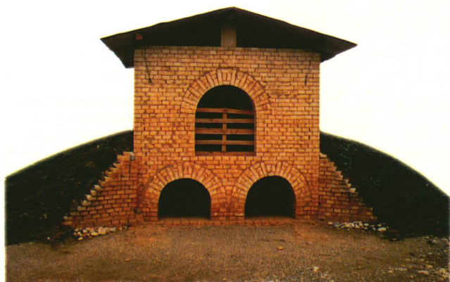
Le four artisanal construit par les chercheurs dans les jardins du monastère de St Urban.
