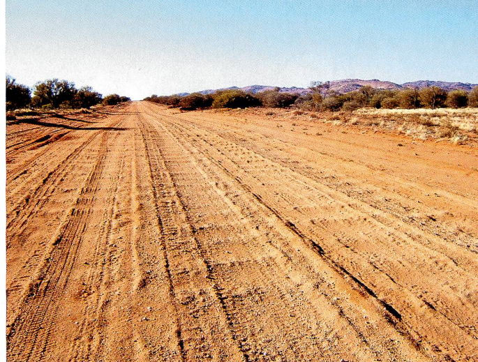
Les rides qui se forment sur les routes non goudronnées (à droite) peuvent être dangereuses. Les chercheurs ont utilisé une table tournante recouverte de sable pour étudier ce phénomène (ci-dessus). Photo à gauche: Nicolas Taberlet, photo à droite: Graham Nicholls
