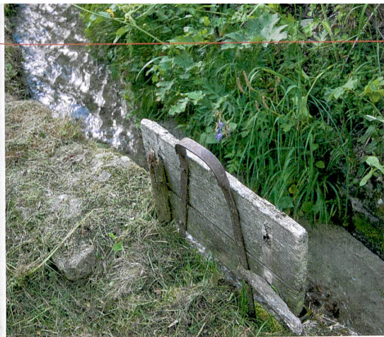
Irrigation traditionnelle en Valais : le bisse « Grossa » au-dessus de Birgisch (à gauche). Au-dessus, une barrière qui n'est plus utilisée et, à droite, un répartiteur d'eau. Page 10 : avant de baigner la prairie, le bisse est d'abord retenu.
