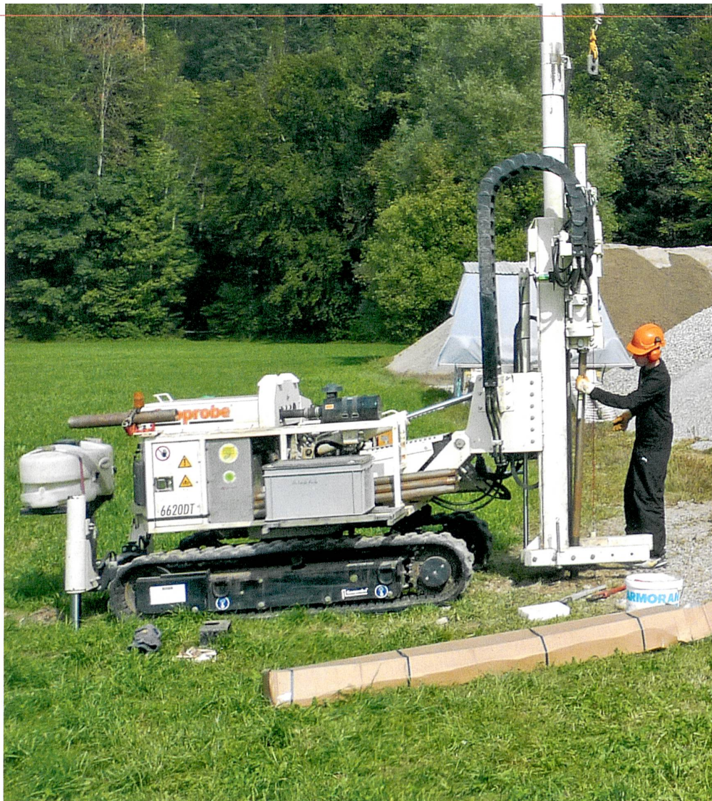
Forage et installation d'une sonde dans l'Emmental. Photo: eawag.ch & chyn.ch
