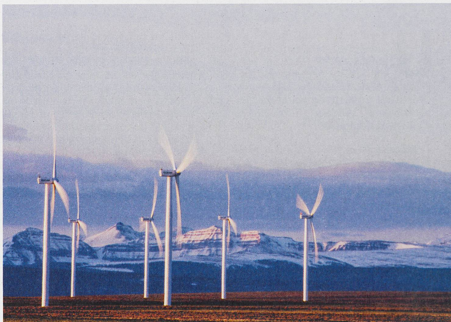
Parc éolien dans le Wyoming. Des simulations montrent que la distance idéale entre éoliennes dans la direction du vent est de huit fois la hauteur du mât. Image: Keystone/Aurora/Chris Noble
