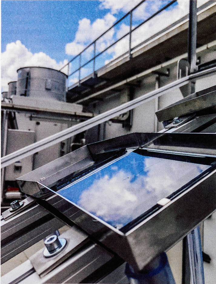
Sur le toit à Muttenz, on teste si du plomb issu des cellules photovoltaïques en pérovskite peut finir dans les eaux pluviales. Photo: mäd
