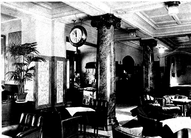
Elektrische Nebenuhr im Vorraum eines Hotels. Die Nebenuhr passt sich voll und ganz der Innenausstattung der Räume an
