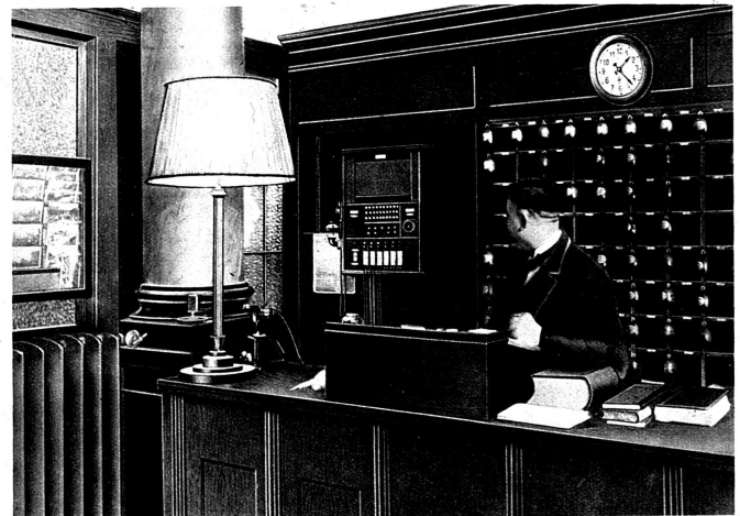
Vermittlungsschrank einer Telefonanlage, automatisches Telefon und elektrische Nebenuhr in der Portierloge eines Hotels
