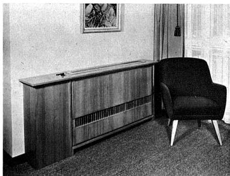
Sulzer-Klimakonvektor in einem Hotelzimmer
