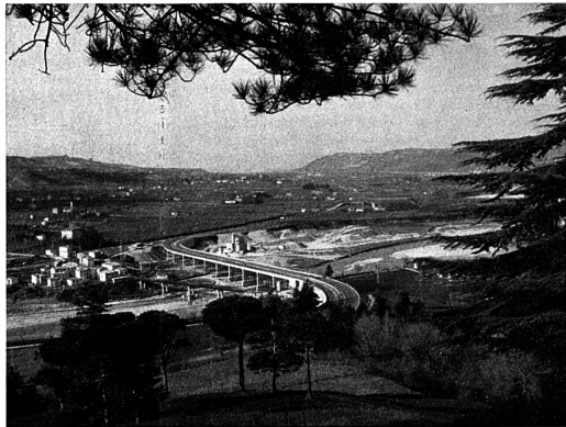
Vue panoramique du pont franchissant la Reno
