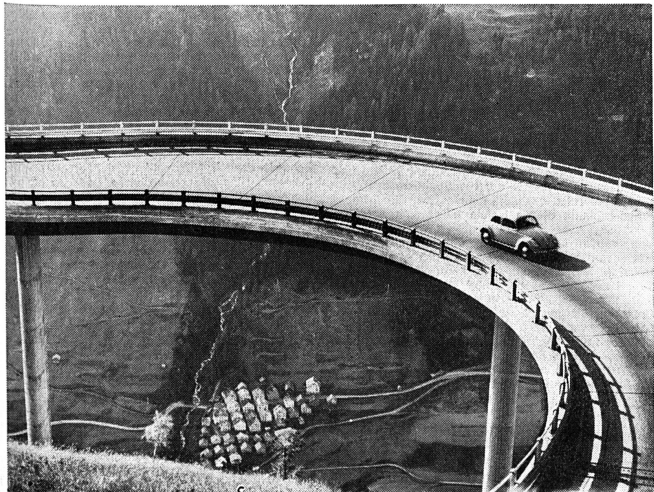
Atemberaubende Strassenbautechnik am neuen Teilstück der N2 oberhalb Airol. In der Tiefe Fontana im Bedrettoal.
