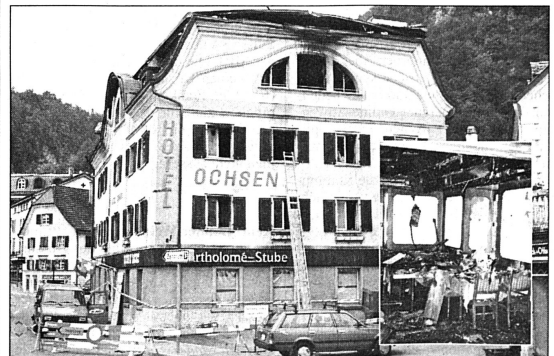
Bis zum Dachstock vom Brand zerstörtes Hotel Ochsen in Bad Ragaz. Ein Übergreifen des Feuers auf das angrenzende Gebäude (hinten) konnte verhindert werden.
