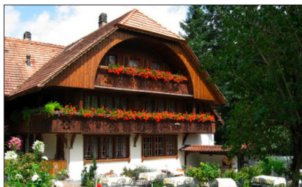
Die historischen Bauten des Hotels Appenberg sind ohne Öl geheizt.
