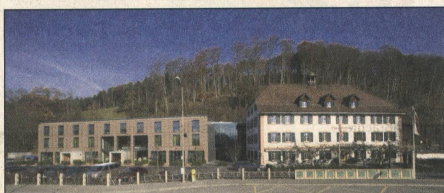
Bad Bubendorf: Denkmalgeschütztes Haus mit modernem Anbau.
