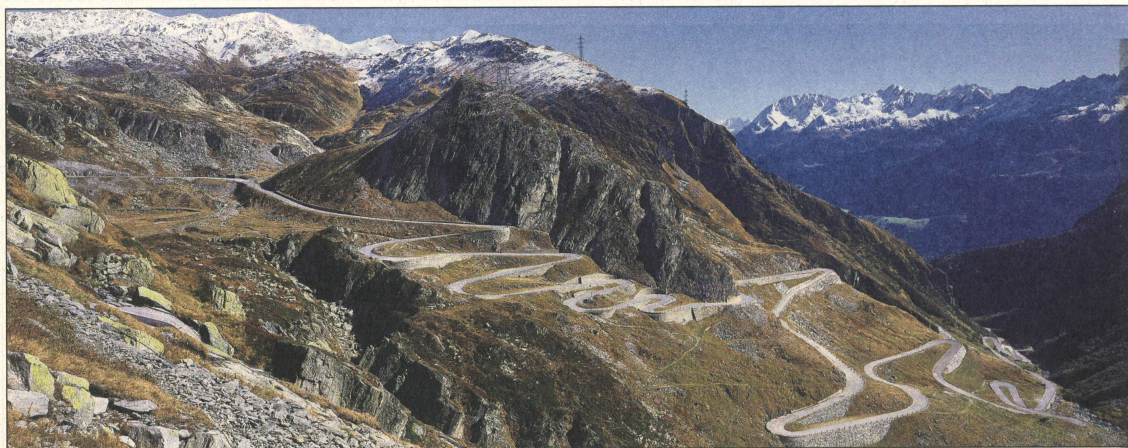
Die berühmte Strasse durch das Tremolatal wurde 1830 eröffnet. Sie überwindet mit 24 Kehren 340 Meter Höhendifferenz.
