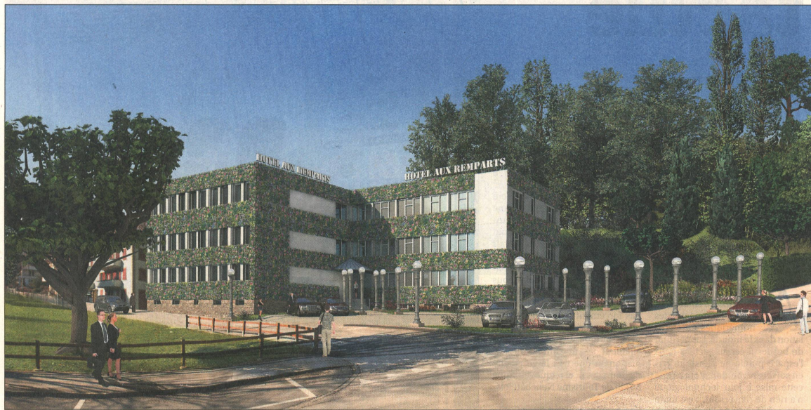
Une vue extérieure du futur Hôtel aux Remparts à Fribourg, dans une ancienne manufacture. Ses façades seront totalement recouvertes de végétation.
