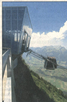
Die Hallen: offene Architektur aus Stahl und Beton.
