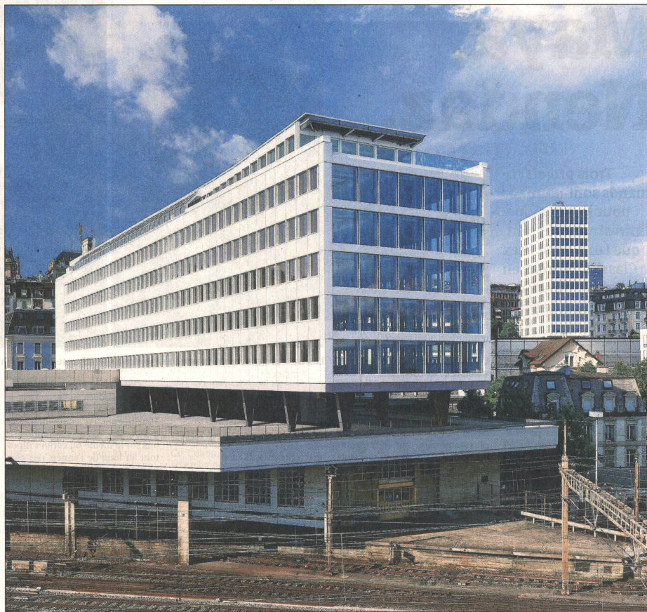
La partie inférieure du bâtiment «Horizon 4-6» devrait accueillir un ou deux hôtels après transformations.
