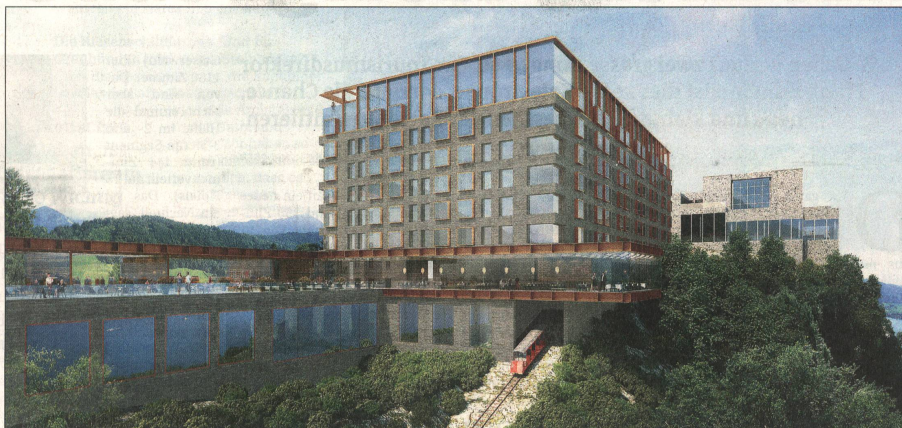
Das neue Bürgenstock-Hotel (zuvor Parkhotel) soll 2017 eröffnet werden. Gestern erfolgte die Grundsteinlegung. Seite 4
