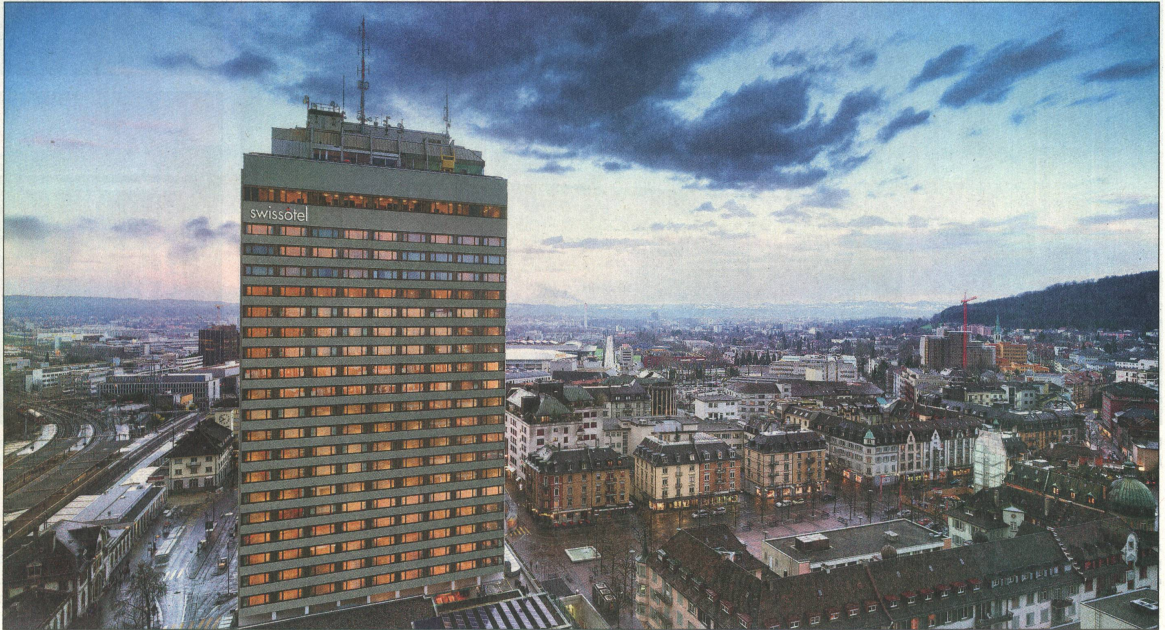
Das Hochhaus in Oerlikon mit dem «Swissôtel Zürich» befindet sich im erweiterten Bauinventar der Stadt Zürich und ist somit schützenswürdig.
