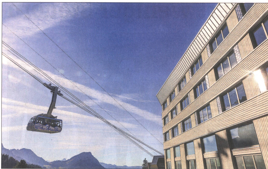
Das neue Säntis-Hotel befindet sich auf der Schwägälp bei der Talstation der Säntis-Schwebebahn.
