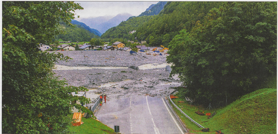
Die vom Engadin kommende Strasse im Bergell kurz vor der italienischen Grenze wurde durch Murgänge zugeschüttet und war nicht mehr passierbar. Keystone/Giancarlo Cattaneo
