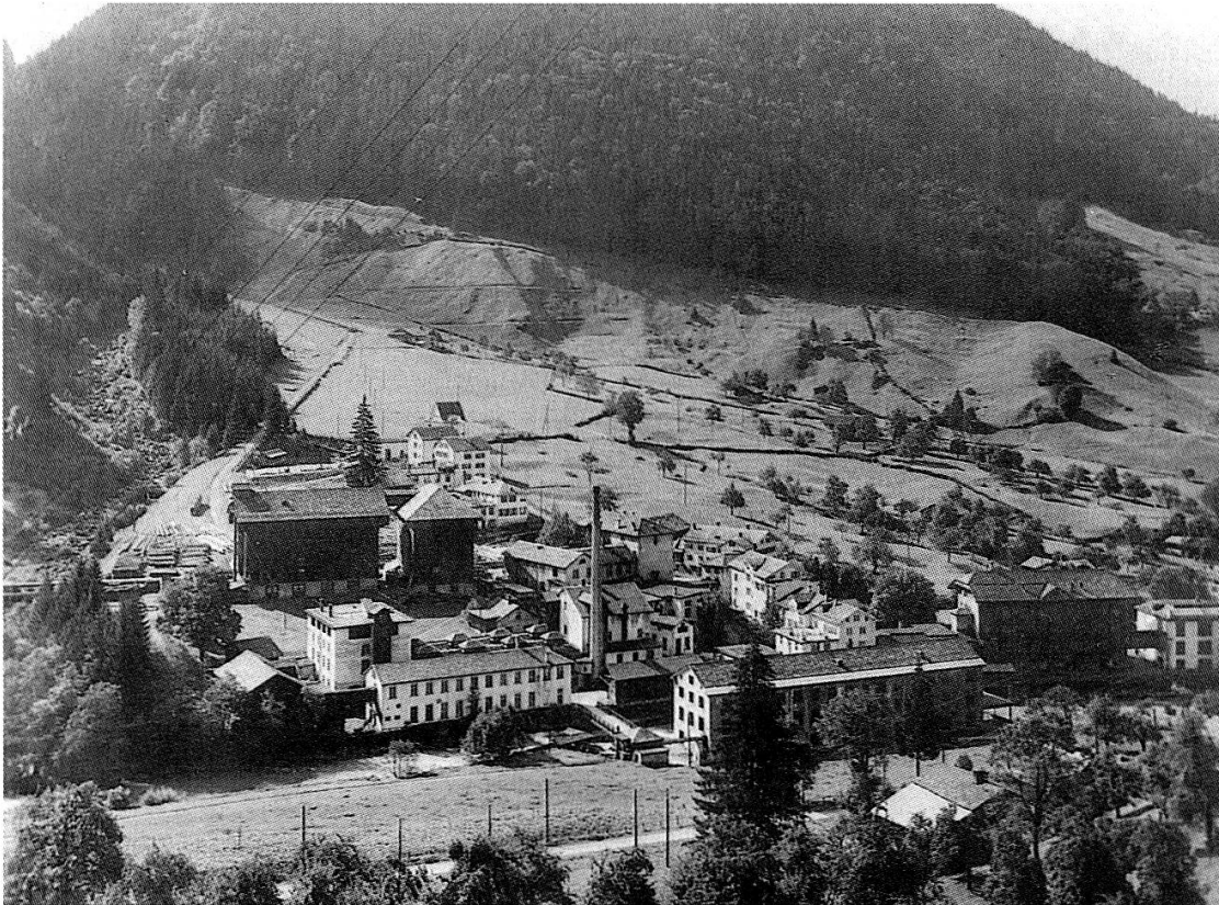
Tschudi & Co., Schwanden: Fabrikanlage «in der Herren», vor dem Abbruch.
