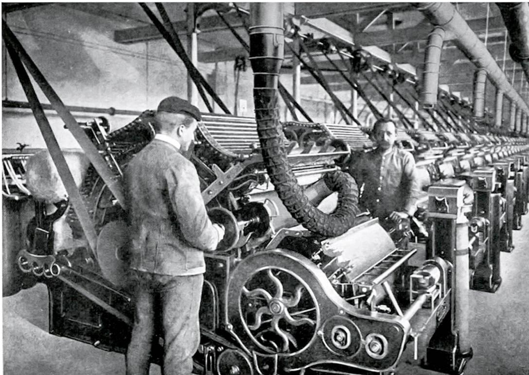
Kardenentstaubungsanlage, Darstellung aus Sommerfeld, S. 111
