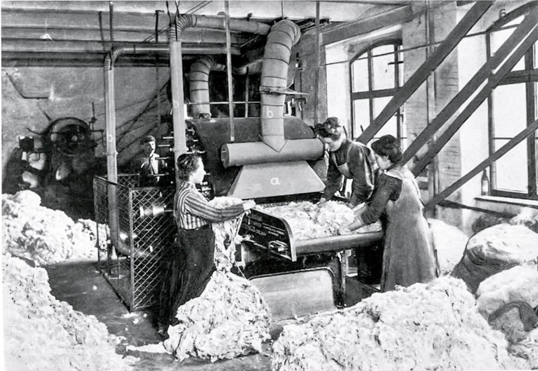
Haderneissmaschine mit Absaugvorrichtung, Darstellung aus Sommerfeld, S. 95
