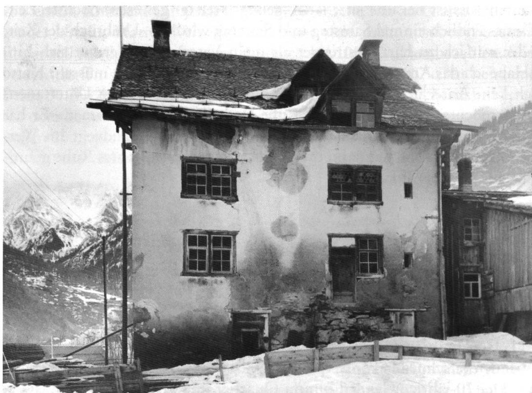
Das Suworowhaus vor der Renovation, Ansicht der Westseite. Das Dach ist teilweise eingestürzt. Besonders augenfällig sind die Feuchtigkeitsschäden an den Mauern und der desolate Zustand des Hauseingangs. (Privatbesitz)
