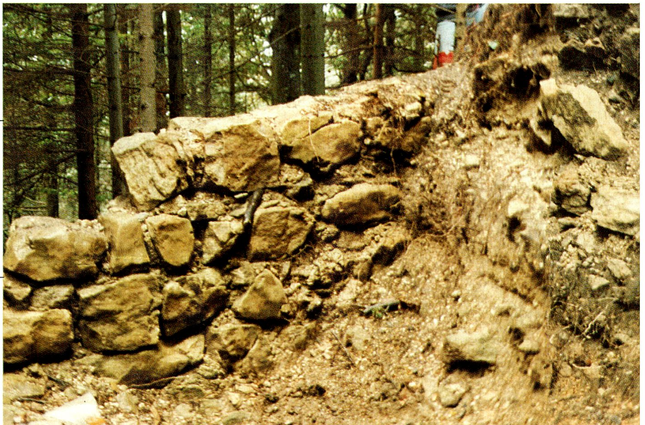
SO-Mauer Inneres Mauerhaupt; Brandrötung des inneren Mauerhauptes
