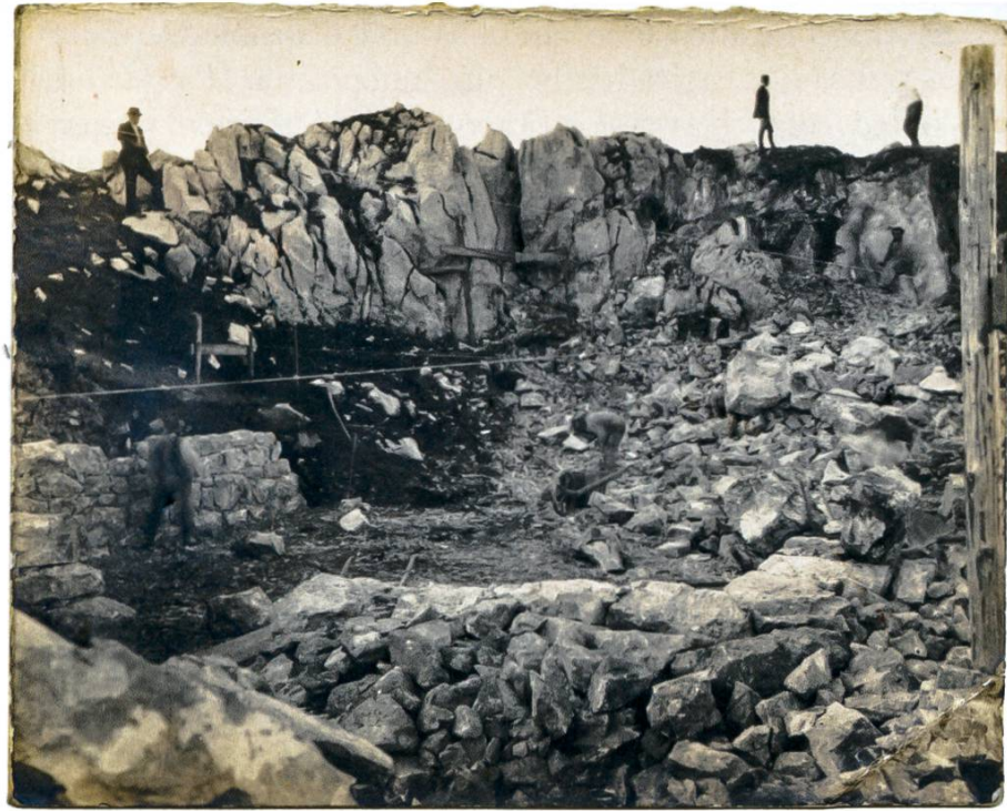
Ein Postkartenrelikt der «Schäfler»-Baustel- le von 1913. (Abb. 2)
