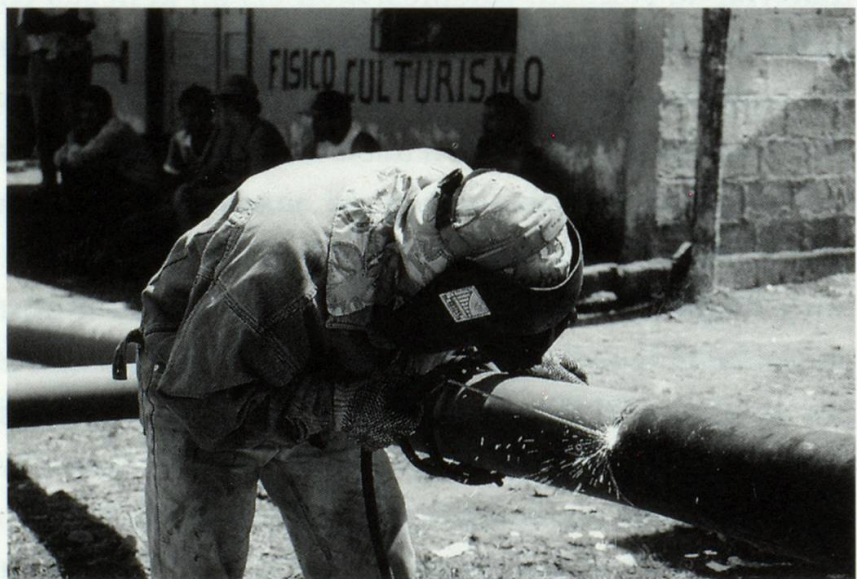
Il puentero Walter.
