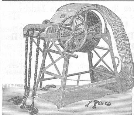
**Zupf-Maschine** für **Polstermaterial** jeder Art, mit Vorrichtung zum Aufdrehen der Stränge.
