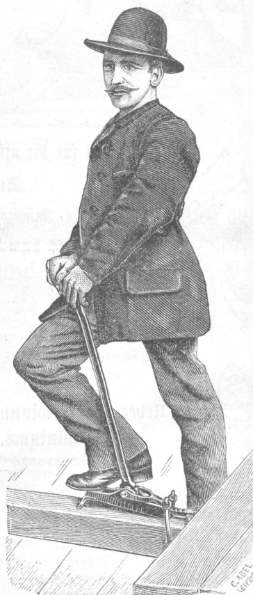
Fußbodenlegeapparat, Patent Plesse.
