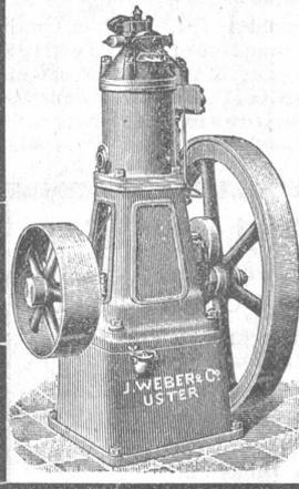
vorzüglicher, bewährtester Konstruktion (System Swiderski-Capitaine, patentiert). In mehr als 3000 Exempl. verbreitet, feststehend und fahrbar, (Lokomobile). Geringst. Petroleumverbrauch, kürzeste Inbetriebsetzung, kleinster Raumbedarf, so-
