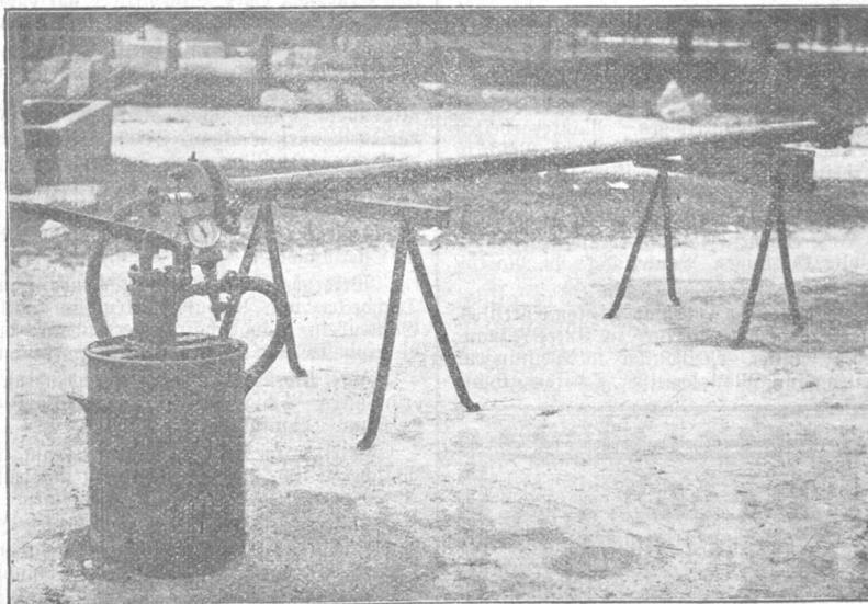
bei Gußleitungen vollkommen erreichen. Bis jetzt mußte zum Beispiel bei Gußleitungen der Zapfen wieder herausgestemmt werden, was mit vieler Mühe und Arbeit verbunden ist. In vielen Fällen konnte daher ein Beschädigen der Leitung oder das Zerbrechen des Zapfens nicht verhütet werden.
