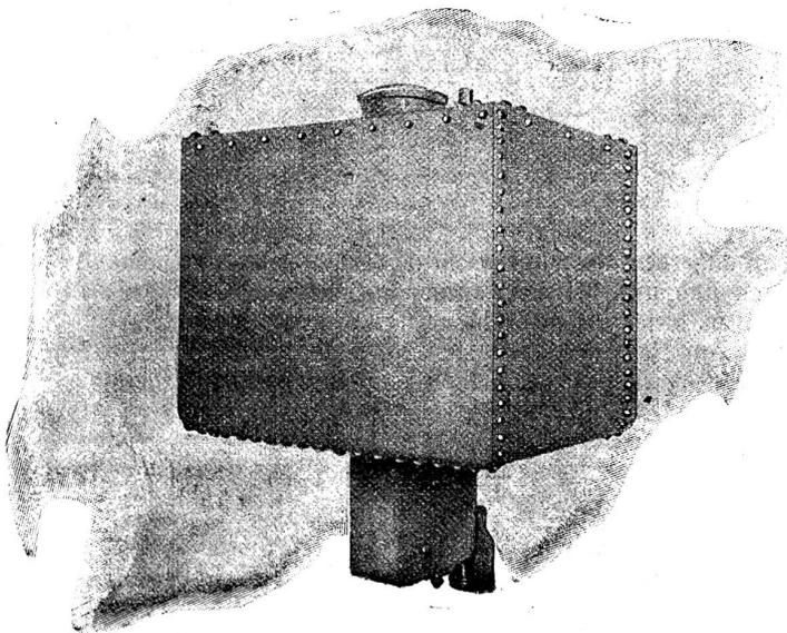
durch den in die Wasserzuführung einzuschaltenden Regulierhahnen beliebig einstellbar und tritt selbst bei tropfenweisem Zufluss ein, sodass der Wasserkonsum ganz genau geregelt werden kann und sparsamer Wasserverbrauch möglich ist. Die Ausführung erfolgt aus galvanisiertem Eisenblech oder auf Wunsch aus Holz mit innerem Walzblei-Ausschlag.
