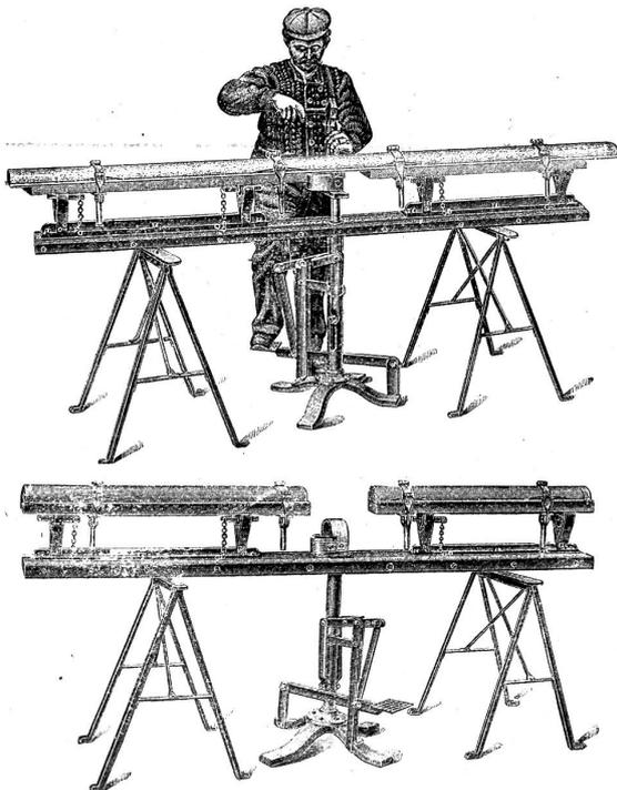
Diese neueste und einfachste Känelniet- und Lötmaschine dient zum raschesten und exakten Nieten und Löten, sowie Auffalzen von Dachkäneln. Zur Verrichtung dieser Arbeiten existierten bis jetzt nur eine große Anzahl von Hilfswerkzeugen, denen aber allen eine gewisse Umständlichkeit anhaftet.
