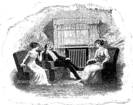
Fig. 2. Moderner Wohnraum mit Zentralheizung.
