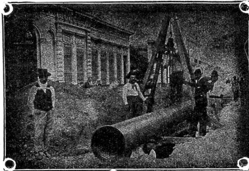
Verlegung überlapptgeschweisster Muffenrohre
