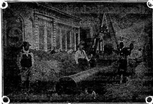
Verlegung überlapptgeschweisster Muffenrohre
