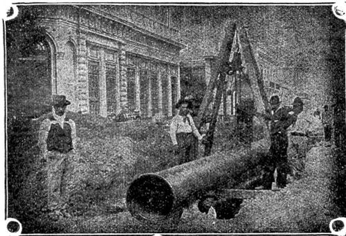
Verlegung überlapptgeschweisster Muffenrohre
