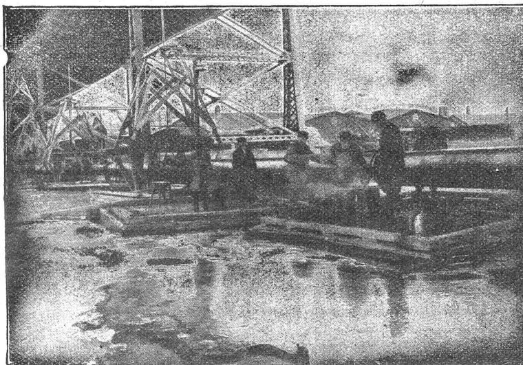
Verlegung eines Dückers aus Flanschenröhren von 600 mm I.W.
