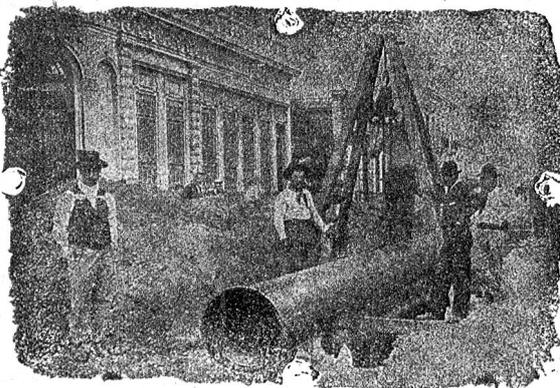
Verlegung überlappgeschweisster Muffenrohre
