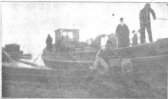
Abb. 4. Auflegen der Betongewichte vor der Absenkung. (21. Dezember 1924.)
