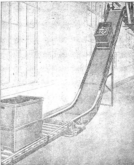
Bild 5. Kettenförderer für Kisten und gleichartige Packungen
