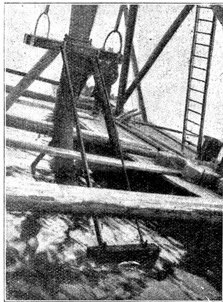
Abb. 4. Freies Ende der Seeleitung, um 90° aufgebogen.
