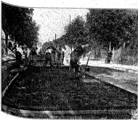
Abbildung 2. Neue Betonstraße Arbon. Eisengeflecht im Unterbeton.
