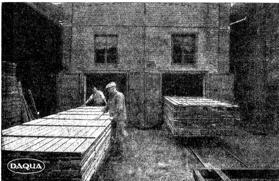
DAQUA - Holztrochnungsanlage in einem Säge- und Hobelwerk.
