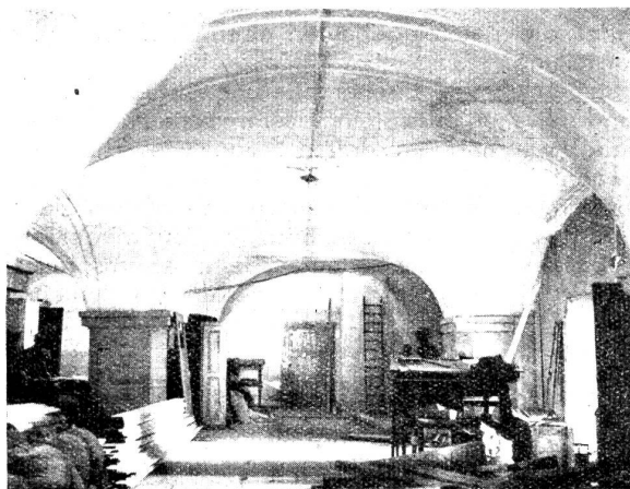
Abbildung Nr. 1. Gewölbte Decke des Erdgeschosses.
